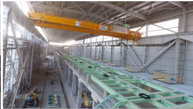
Construction AP5, Acerinox Europa
