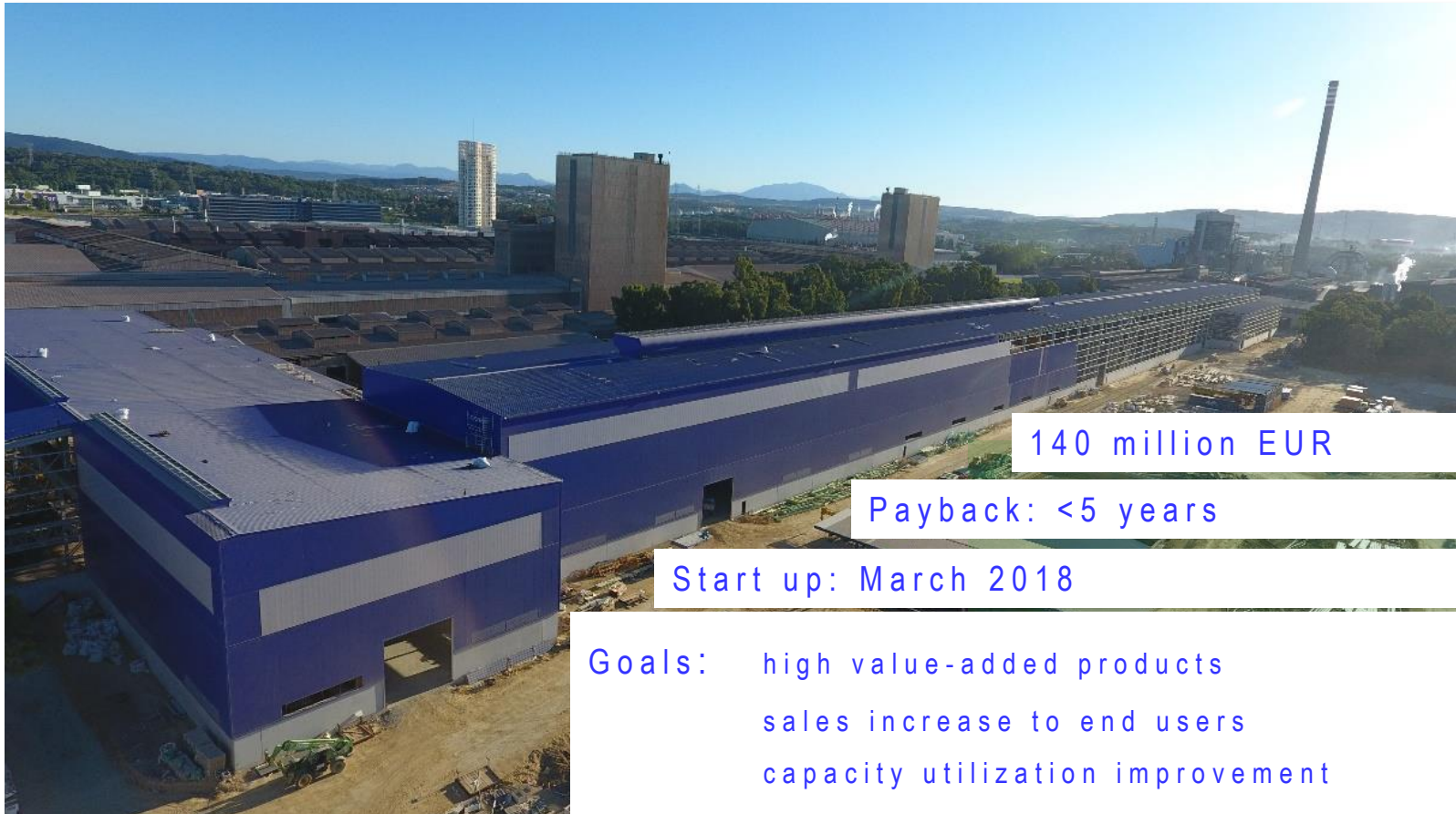
Construction AP5, Acerinox Europa
