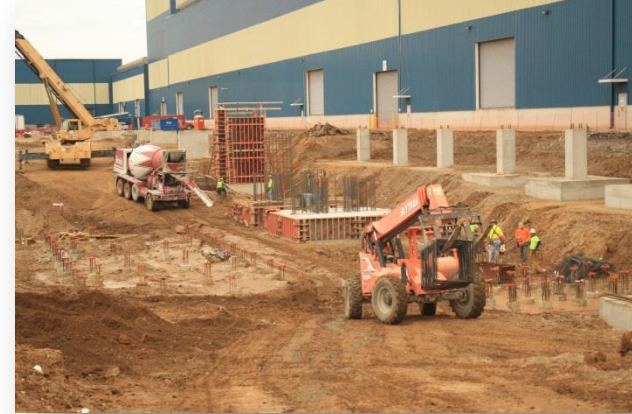
Construcción ZM, NAS
