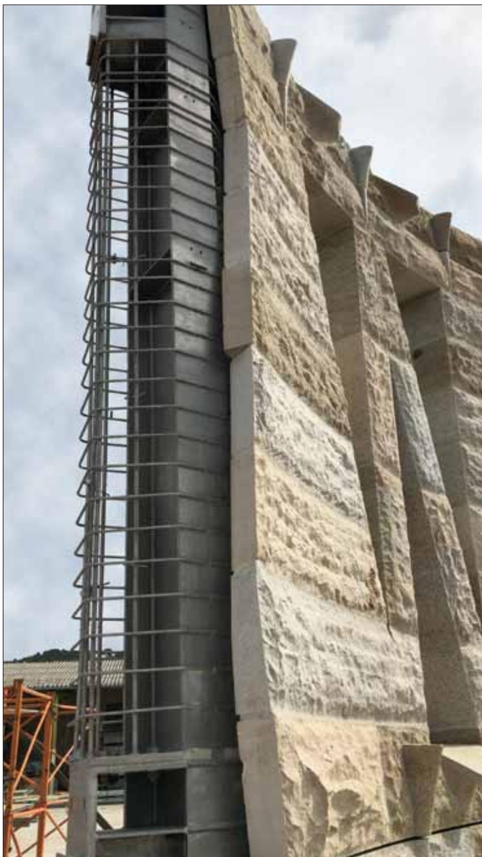
*Barra corrugada de Roldán utilizada como armadura de acero inoxidable en la construcción de la Basílica de La Sagrada Família en Barcelona.*
